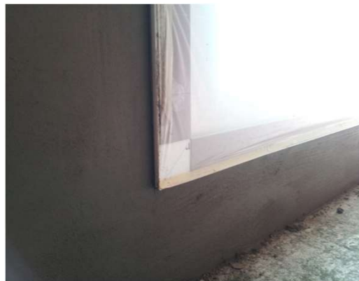
▲ 미장 작업 후
