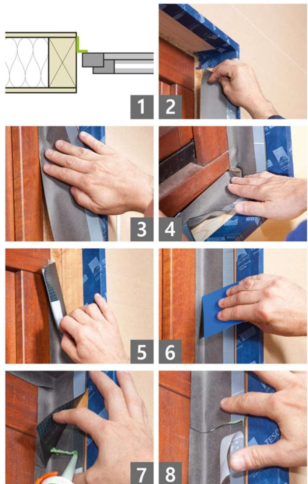
목재, 창호 시공 후
